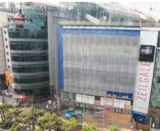
Fassade vor Revitalisierung
