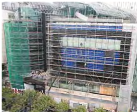
Fassade während Revitalisierung
